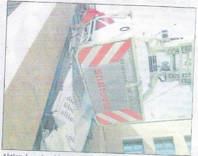
Aktion beendet: Montagekünstler Hannes Neubauer entfernt das „Lesezeichen“ von der Fassade der Sparkassen-Filiale in der Almsstraße.
